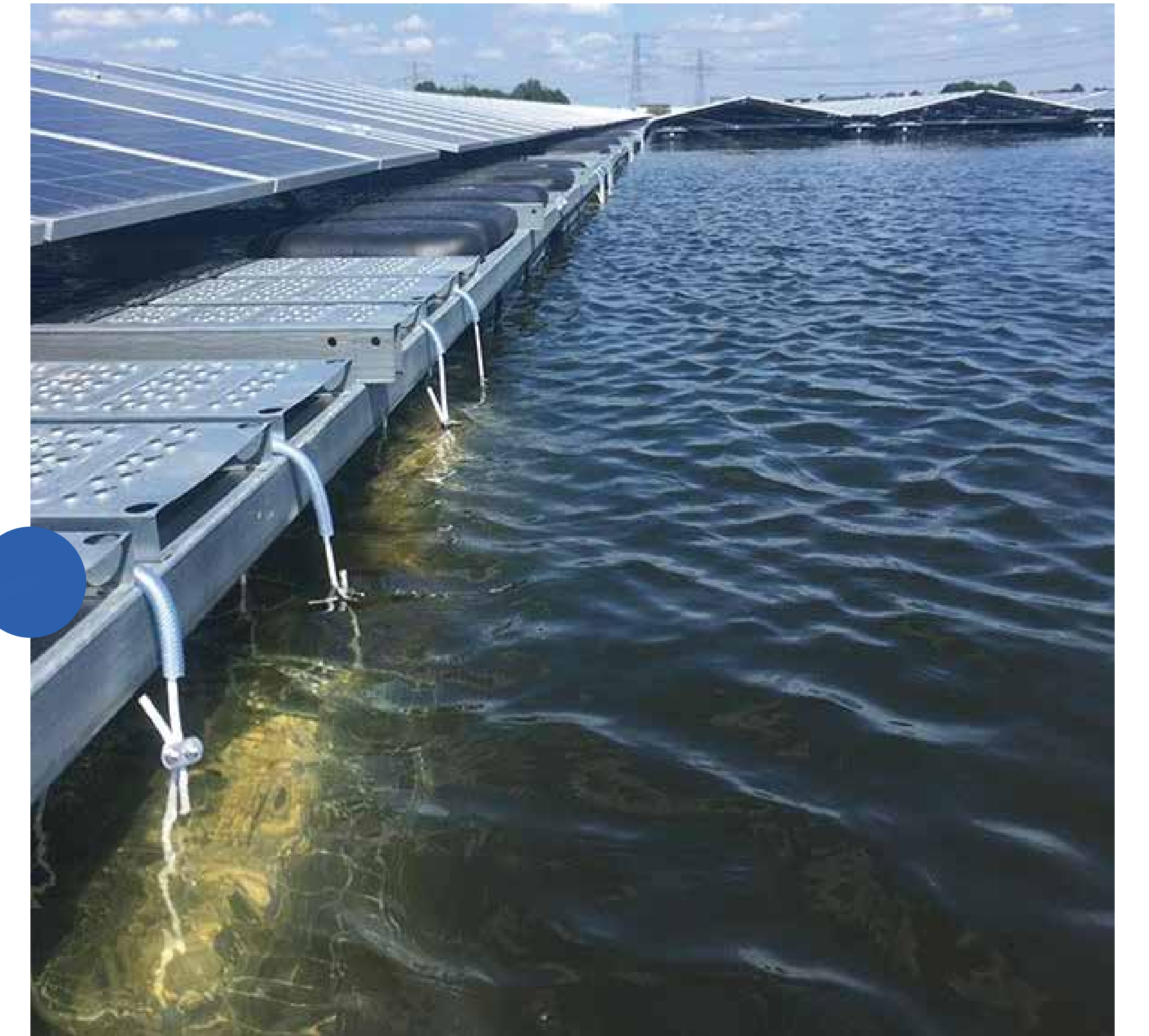
Biohut voor aanhechting van schelpdieren
